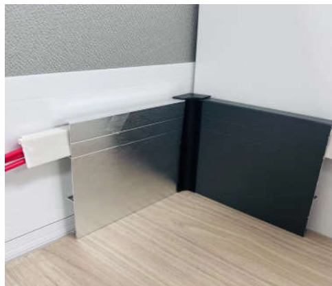
图示15 线槽安装完阴角效果
