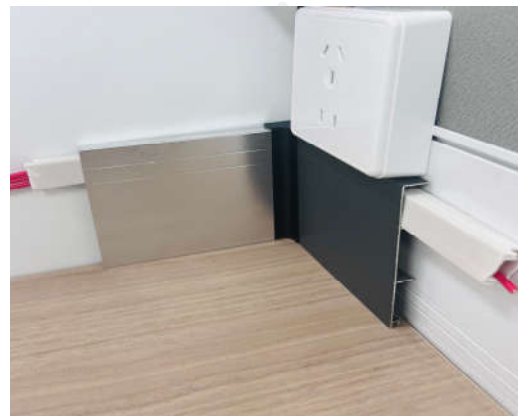
图示16 踢脚线槽及插座安装完效果
