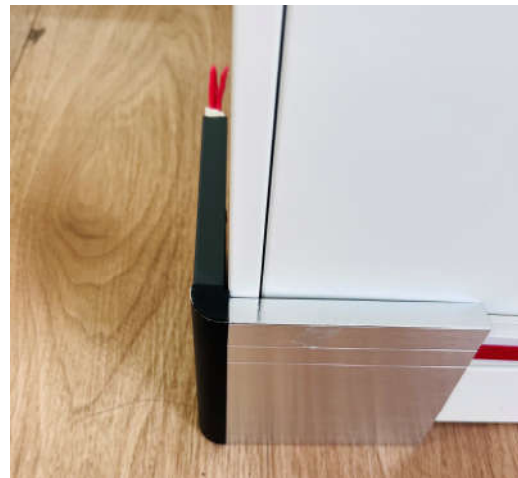
图示14 线槽安装完阳角效果
