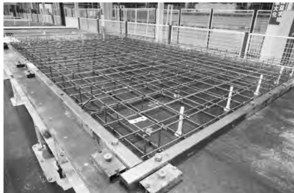
图 2-6 钢筋与预埋件安装
