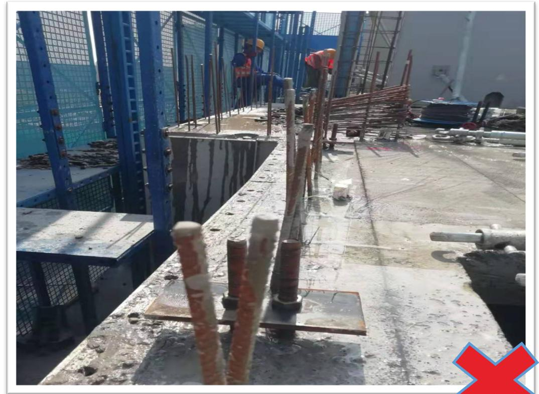
问题：凿毛工艺粗糙，浮渣未清洗，钢筋无校正
