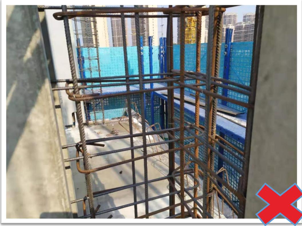
问题：钢筋绑扎没有用钢丝固定
