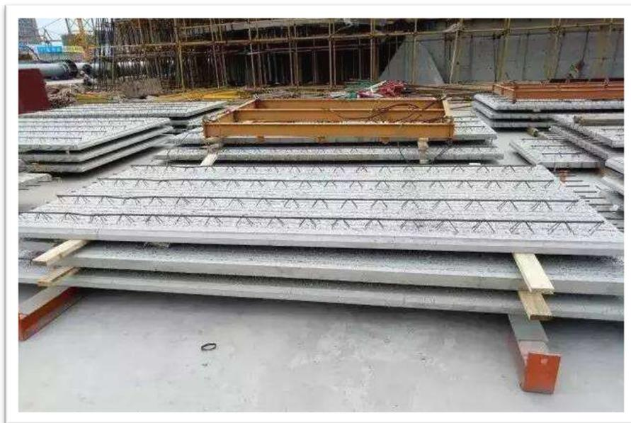
垫木方向与桁架钢筋方向保持垂直；垫木距板端200mm，中间枕木间距不大于1500mm；堆放过程中小板应该放置在大板上方，叠放层数不宜超过6层。
