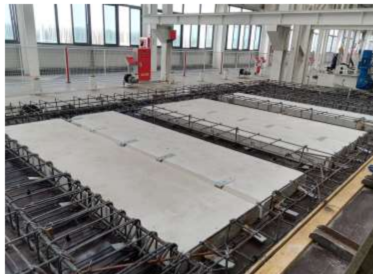
A面条板及钢筋笼安装
