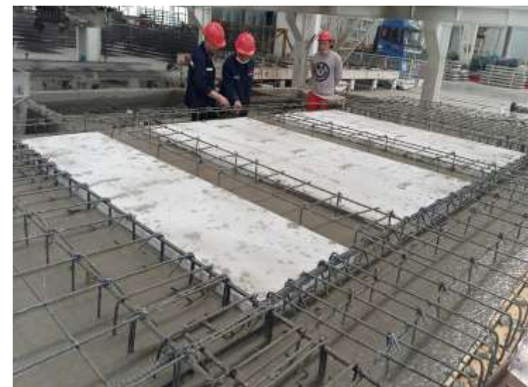
A面混凝土浇筑
