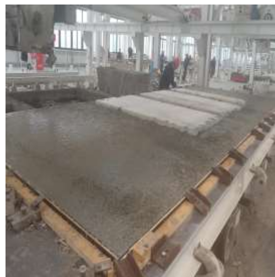
B面混凝土浇筑
