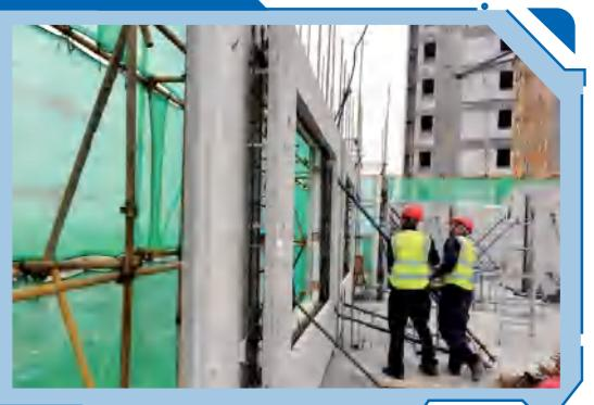
SPCS 构件容错率高，没有套筒注浆工序，吊装难
