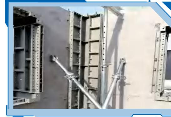
模板及模具 SPCS 连接段小于灌浆套筒，模板减少，
