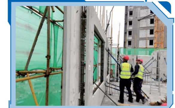
SPCS 构件容错率高，没有套筒注浆工序，吊装难
