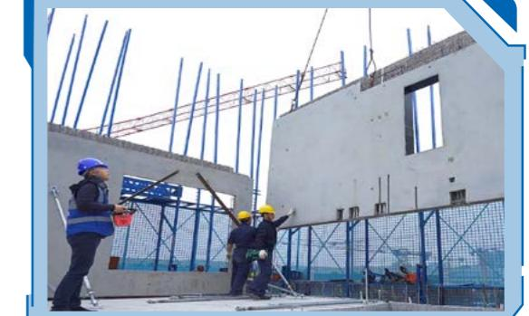
SPCS 没有灌浆套筒的套筒及灌浆料，辅材费便宜。
